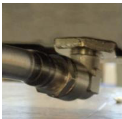
2 Collegare lo scarico dell'acqua di condensa ad un tubo
